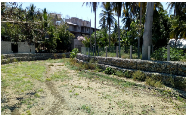
Muren som nyligen byggts upp i ett försök att stoppa kommande översvämningar från foden som har sin bana förbi Piña Palm
